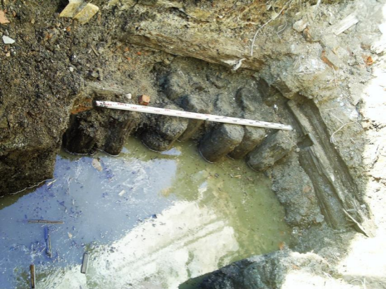
Рис. 5. Свайный фундамент церковной ограды
