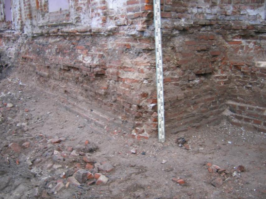
Рис. 2. Общий вид на фундамент церкви с юго-востока.
